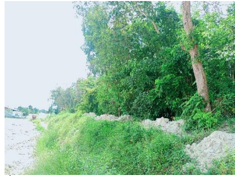
รูปที่ 2-14: ทำคันทำนบกั้นดินขนาดความกว้างด้านบน ประมาณ 2 เมตร สูงประมาณ 2 เมตร และความกว้างด้านล่างประมาณ 8 เมตร
